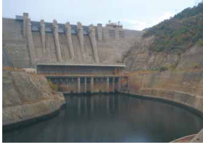
Υ/Η φράγμα Πλατανόβρυσης.
